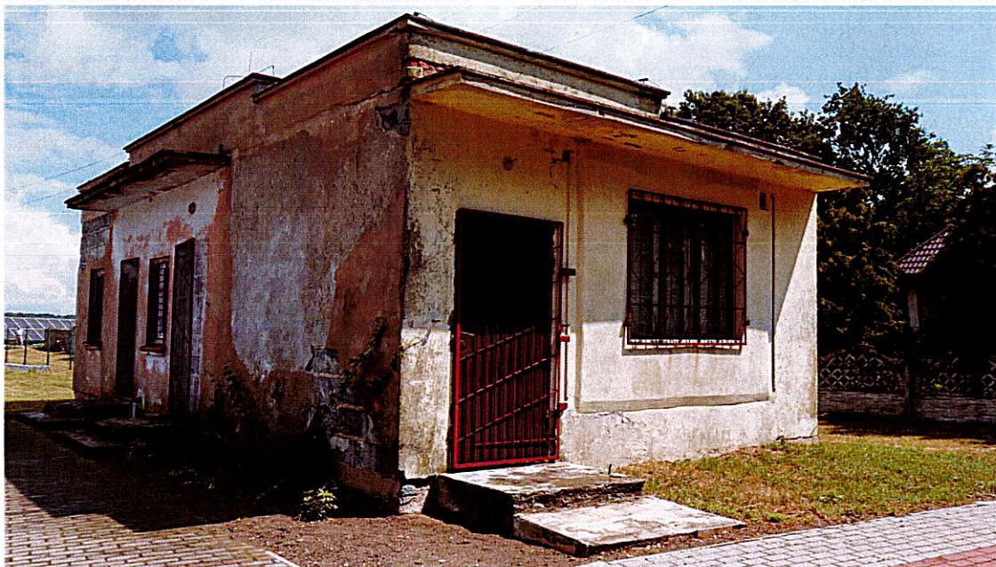
Budynek dawnego sklepu – obecnie skład sprzętu na potrzeby OSP.
